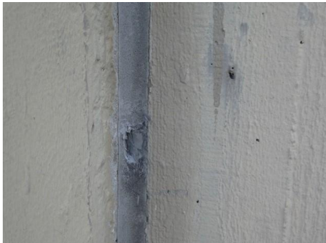
PCB-haltige Fugendichtungsmasse
