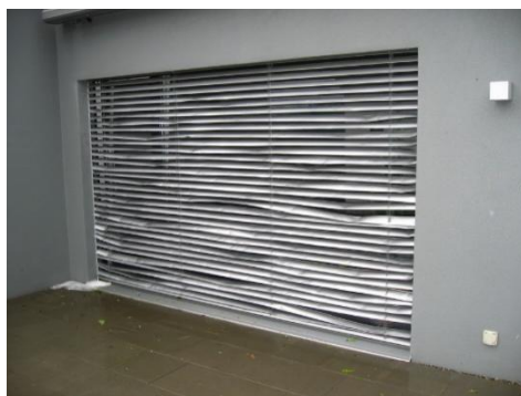
Beschädigter Sonnenschutz
